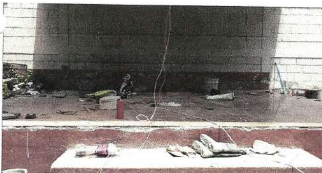
Foto 11: Sustitución de piso cerámico antideslizante
