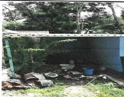
Foto 8: Instalación de pila
