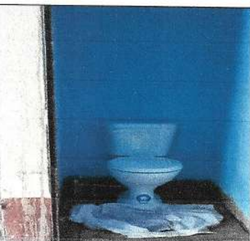
Foto 9: Suministro e instalación de inodoro y accesorios, suministro e instalación de piso cerámico antideslizante
