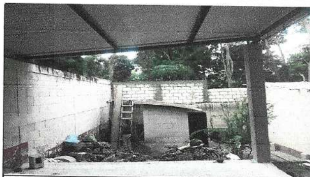
Foto 10: Reparación de muro perimetral de block
