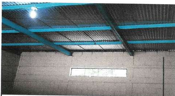
Foto 12: Ampliación de ventana y colocación de cedazo
