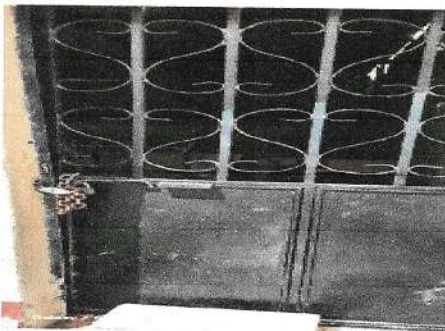
Foto 5: Mantenimiento de Puerta metal 2.0 m x1.m
