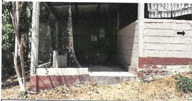
Foto 1: Remozamiento de muros de la cocina, sustitución de tela maya por muro de block
