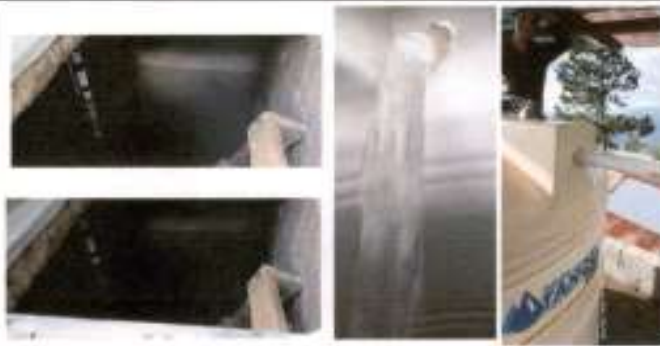
Foto 8 Instalación de bomba y prueba de la misma 100% ejecutado.
