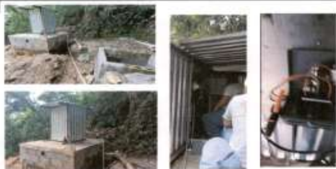
Foto 7 Construcción del Tanque e instalación eléctrica del funcionamiento de la bomba 100% ejecutado.
