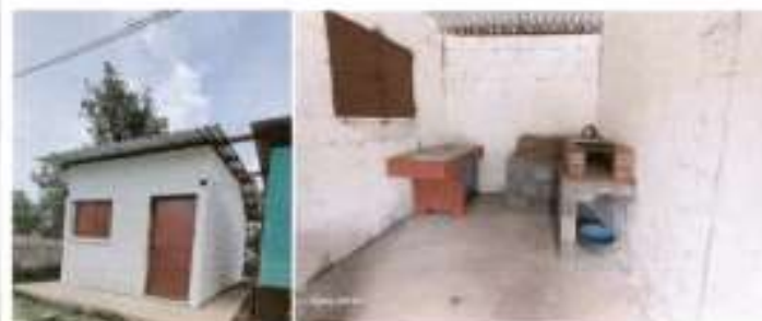
Foto 9 Ampliación de cocina de 3x3 m2, construcción de hornilla, instalación de gila de cemento. 100% Ejecutado.
