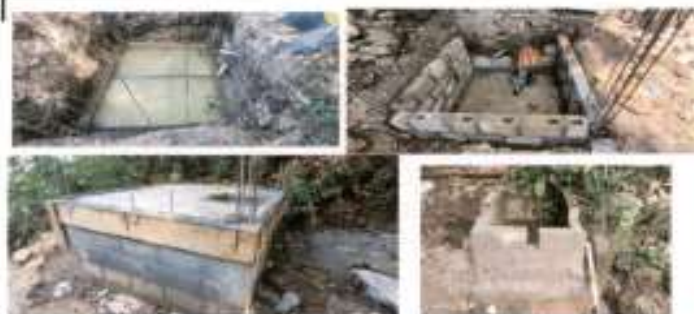
Foto 7 En proceso de construcción de tanque de 2x2 m2. Y mejoramiento del tanque de captación.
