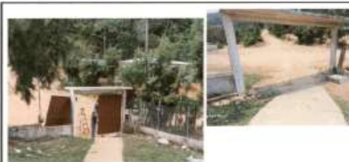
Foto 4: En proceso de la sustitución del portón de malla, por uno de estructura metálica.
