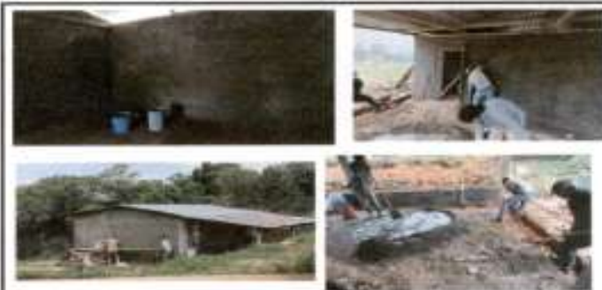
Foto 6: En proceso de Repello de aula de aula de adobe.
