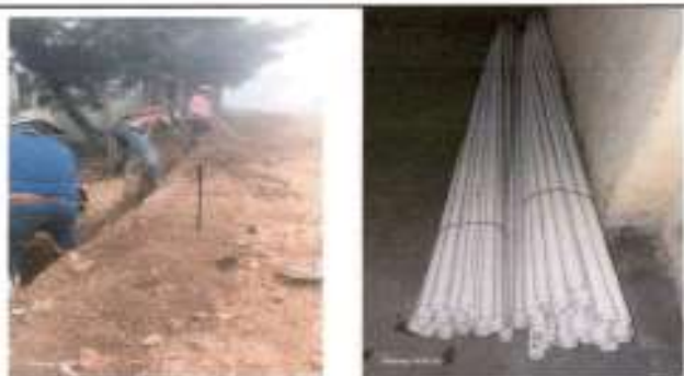
Foto 3: Realizando la zanja para colocar la tubería de 1 1/4 que se compró para el proyecto de agua potable.
