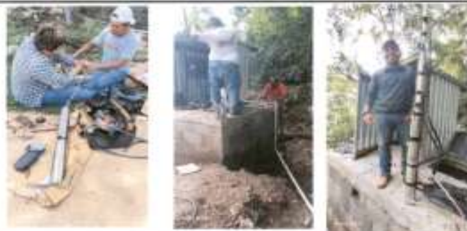
Foto 8 En proceso de Sustitución de bomba de agua sumergible, previo a la instalación y realizar la prueba.
