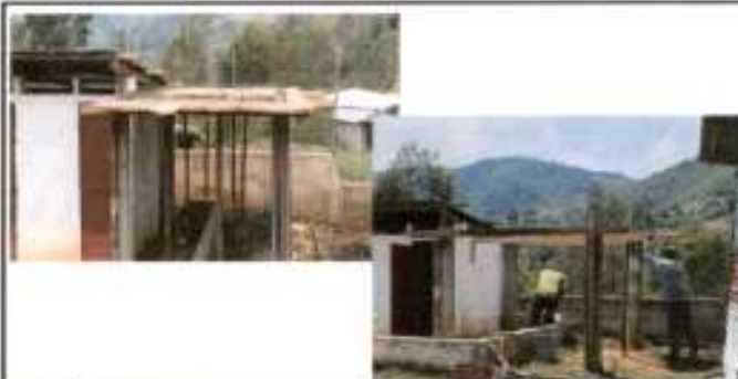
Foto 2: En proceso de fundir la terraza.
