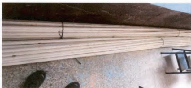
Foto 3: Sustituir la red de tubería de 3/4 por la potencia de la bomba se necesita de 1 1/2 para 350 metros de distancia.
