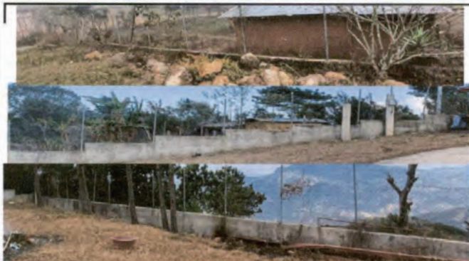
FOTO 1 Subir 7 Hiladas de Block, reforzar con columnas y soporte las hiladas de block, corresponde a 41 m largo por lado, 1.50 cm de alto. haciendo un total de 241 m2
