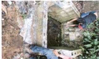
Foto 7 Ampliación del Tanque del pozo de donde se instalará la bomba.
