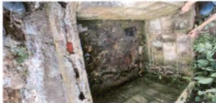
Foto 7 Ampliación del Tanque del pozo de donde se instalará la bomba.
