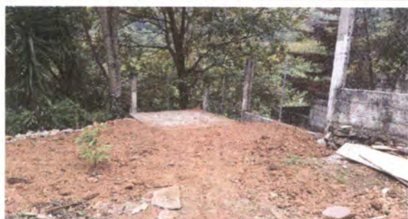
Foto 5 Reparación de fosa séptica, repello, pared y entronque para su uso
