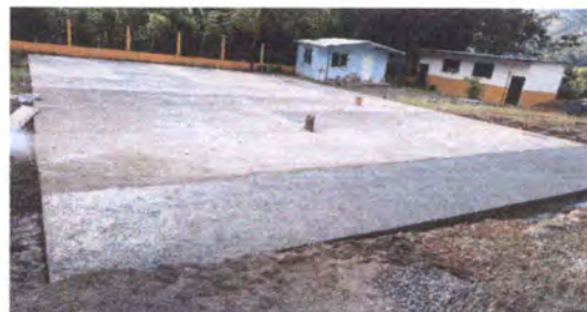
Foto 6 Aplicación de torta de concreto (Fundición Losa de Patio)
