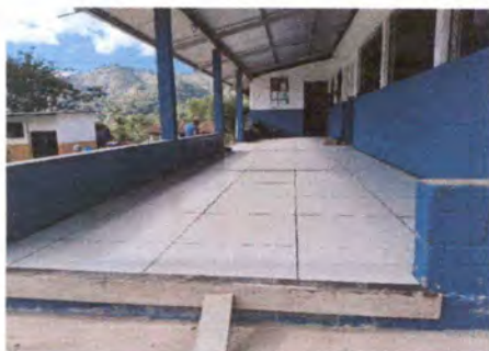
Foto 3 sustitución de piso cerámico
