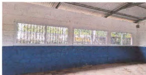
Foto 2 fabricación e instalación de ventanas de vidrio
