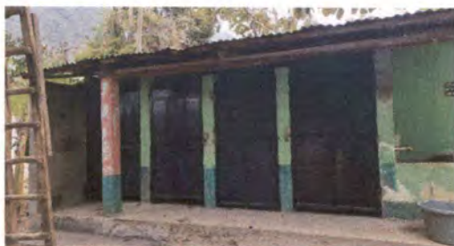
Foto 1: Mantenimiento de estructura, lijado, reparación y pintura de puertas de servicios sanitarios.
