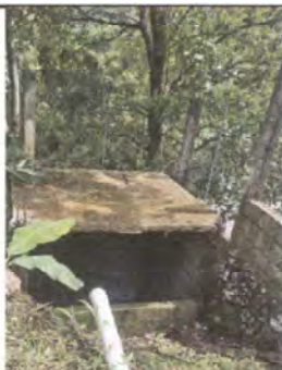
Foto 5: Reparación de fosa séptica, repello, pared y entronque para su uso
