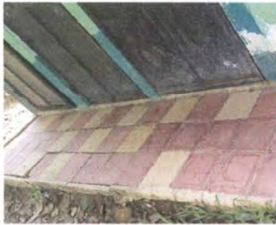
Foto 1: Mantenimiento de estructura, lijado, reparación y pintura de puertas de servicios sanitarios.
