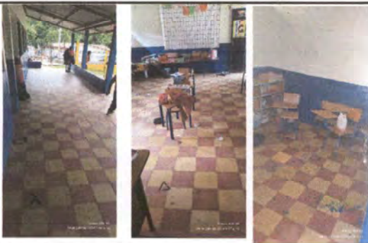
Foto 3: Sustitución de piso cerámico
