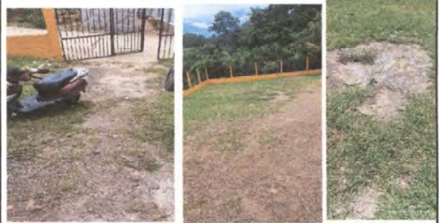
Foto 6: Aplicación de torta de concreto.
