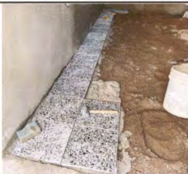
Foto 3: Colocación de piso de granito en cocina
