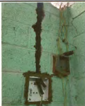
Foto7: Reparación de sistema eléctrico
