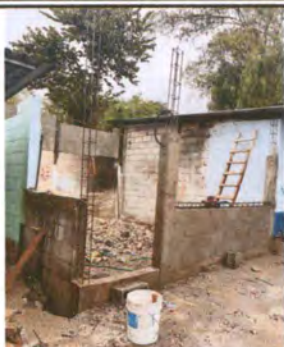
Foto 1: Remozamiento de muros de cocina
