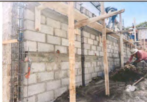
Foto 10: Reparación de muro perimetral de block
