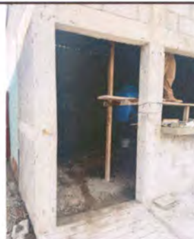
Foto 4: Sustitución de puerta de metal
