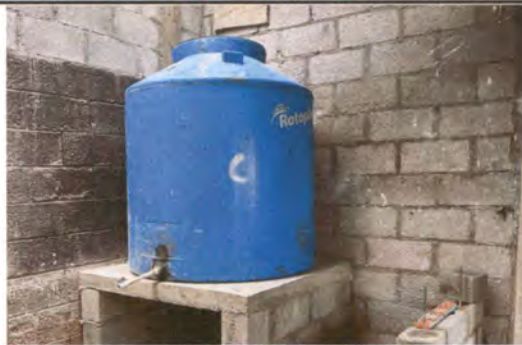
Foto 8: Sustitución de accesorios depósito de agua
