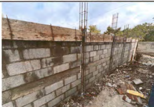
Foto 9: Reparación de muro perimetral de block
