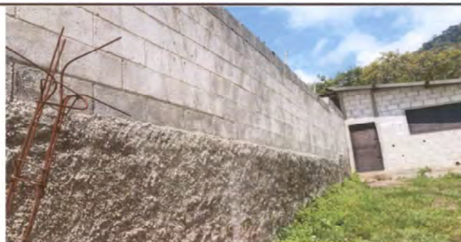
Foto 10: Reparación de muro perimetral de block
