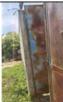
Foto 9: Reparación de muro perimetral de block
