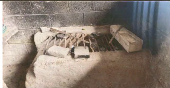
Foto 2: Sustitución de bases para estufa, colocación de plancha y chimenea
