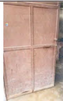
Foto 4: Sustitución de puerta de metal
