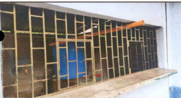
Foto 5: Mantenimiento de balcón de cocina
