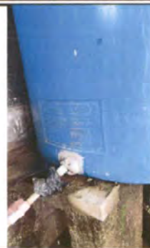
Foto 8: Sustitución de accesorios depósito de agua
