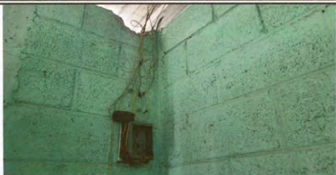
Foto7: Reparación de sistema eléctrico
