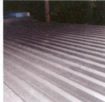
Foto 4: Sustitución de Lámina de la Biblioteca
