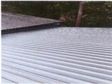
Foto 3: Sustitución de lámina de la Biblioteca
