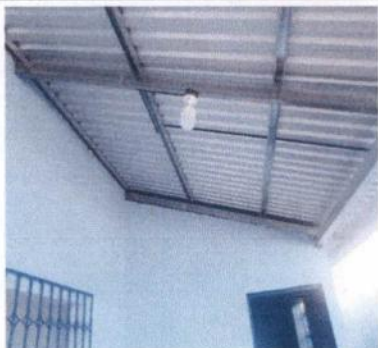
Foto 15: Suttitucion de Sistema Eléctrico
