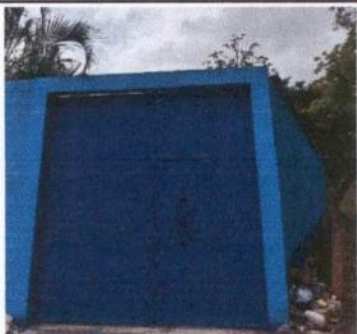
Foto 17: Pintura para portón
