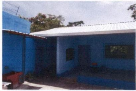
Foto 2: Canal de agua lluvia de la Cocina
