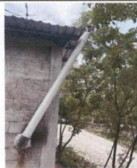
Foto 12: Sustitucion de Chimenea
