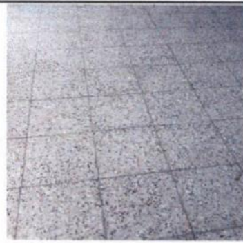
Foto 4: Sustitución de piso
