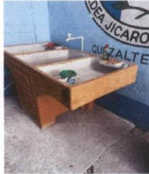
Foto 16: Suttitución de Pila de Concreto
