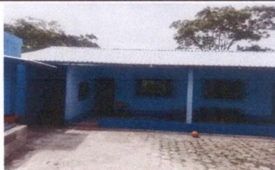
Foto 18: Suttitución de Lámina
