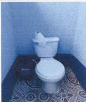
Foto 9: Sustitución de Sanitario
