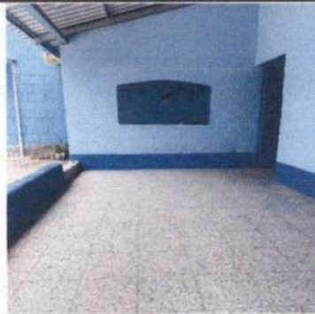
Foto 8: Pintura de Interior y Exterior
