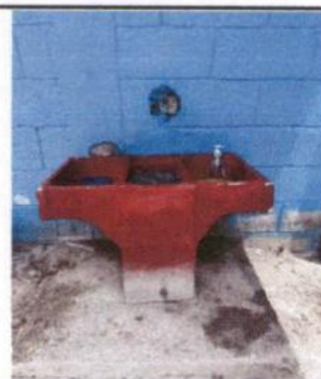
Foto 6: Sustitución de Pila de concreto para niños
