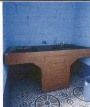
Foto 10: Sustitución de Pila de Concreto
