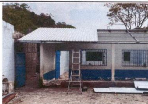
Foto 18: Sustitucion de lámina
