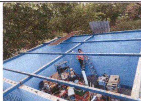
Foto 4: Sustitución de Lamina de la Biblioteca
