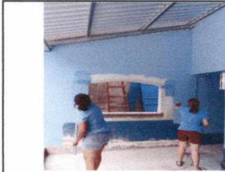
Foto 8: Pintura de interior y exterior
