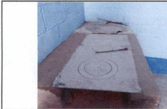
Foto 11: Sustitucion de plancha
