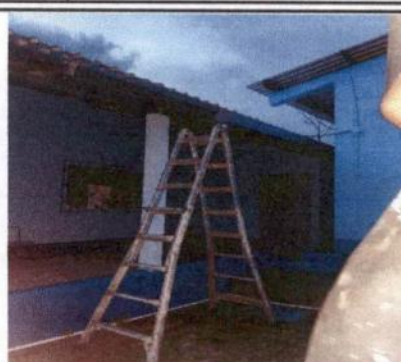
Foto 14: Sustitución de canal
