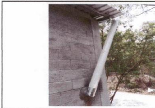
Foto 12: Sustitucion de chimenea
