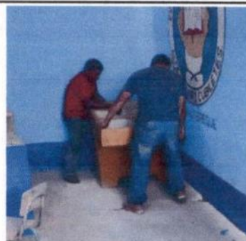
Foto 16: Sustitución de Pila
