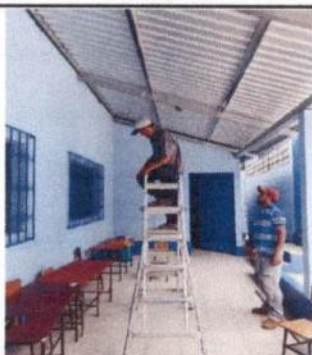
Foto 15: Sustitucion de sistema eléctrico
