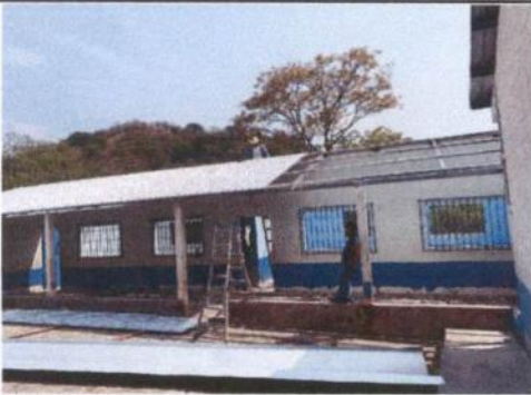
Foto 1: Sustrución de lámina y estructuta de metal
