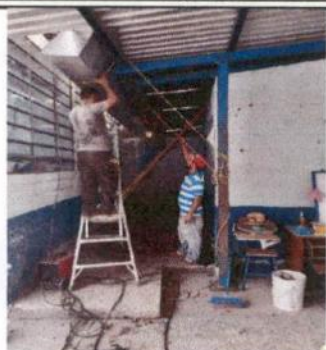
Foto 13: Sustitucion de Canal
