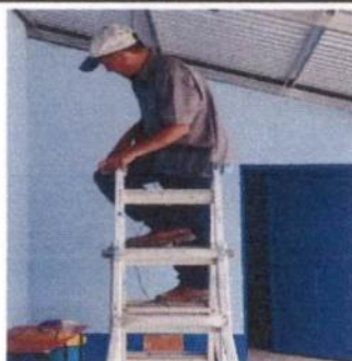
Foto 5: Sustitución del Sistema Eléctrico
