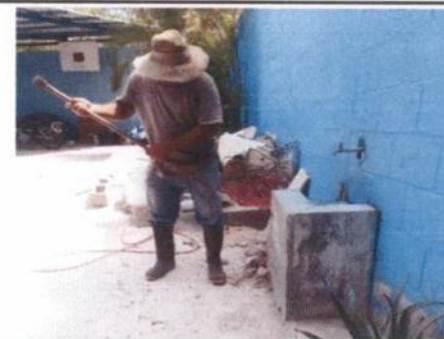
Foto 6: Sustrución de Pila de concreto para niños
