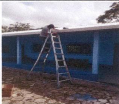
Foto 1: Canal de agua Pluvial corredor
