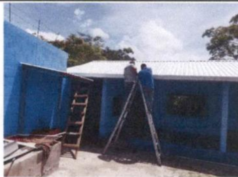
Foto 2: Canal de agua pluvia de la Cocina
