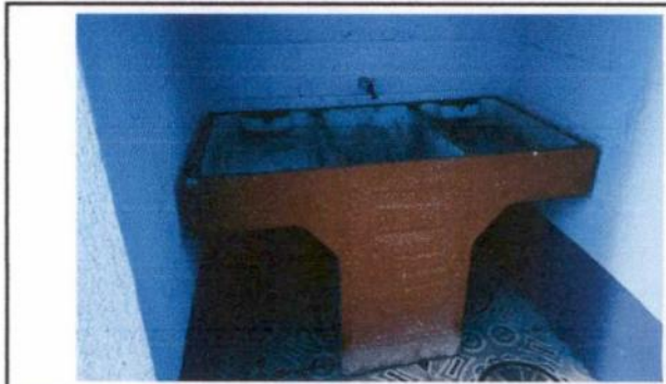
Foto 10: Sustitucion de pila de concreto
