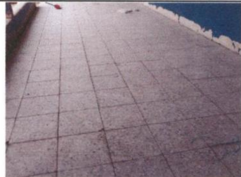
Foto 4: Sustrución de piso
