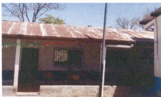
Foto 1: Sustrucción de lámina y estructura de metal
