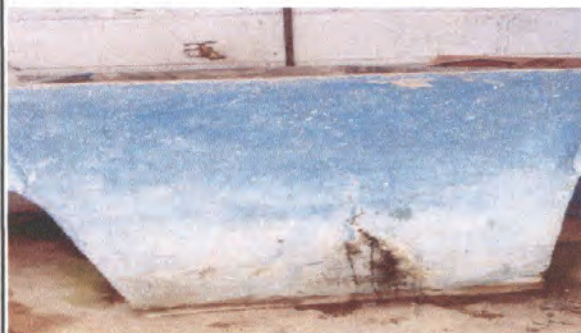
Foto 10: Sustitucion de pila de concreto
