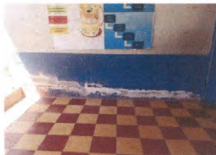
Foto 8: Pintura de interior y exterior
