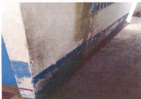
Foto 7: Pintura de interior y exterior
