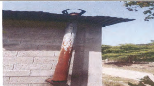
Foto 12: Sustitucion de chimenea
