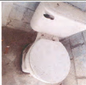
Foto 9: Sustitucion de sanitario
