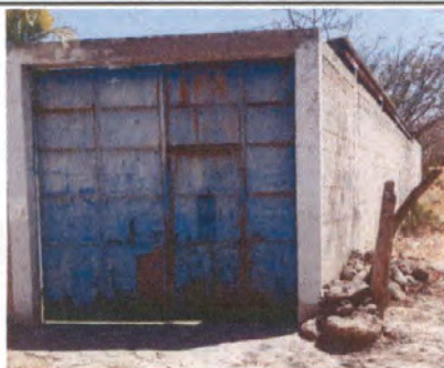
Foto 17: Pintura para Porton
