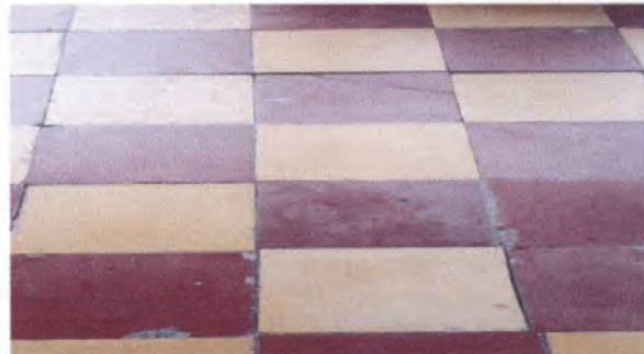
Foto 4: Sustrucción de piso
