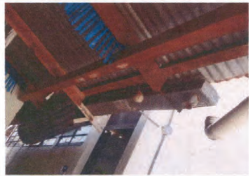
Foto 14: Sustrucción de canal
