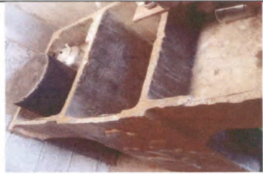
Foto 16: Sustrucción de Pila
