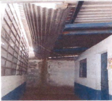
Foto 13: Sustrucción de Canal
