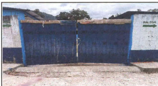
Foto 6: Mantenimiento a portón de metal
