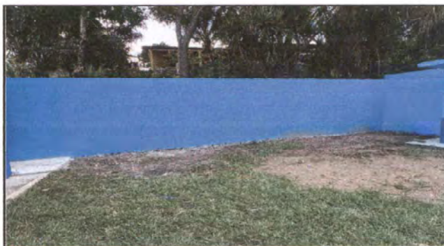
Foto 4: Pintura en muros exteriores e interiores
