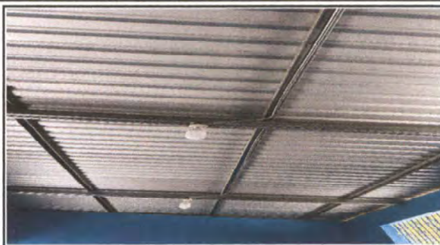
Foto 2: Sustitución de lámina, por lámina troquelada
