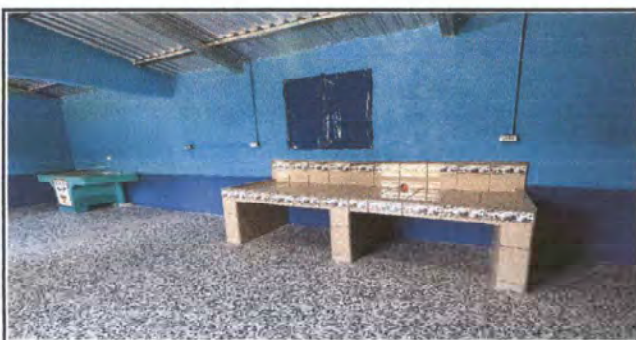
Foto 11: Repello de paredes de cocina
