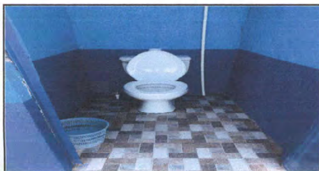
Foto 5: Sustitución de inodoros
