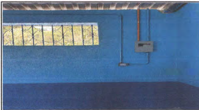
Foto 8: Reparación de cableado eléctrico
