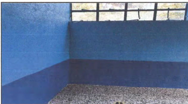
Foto 10: Repello de paredes de aula
