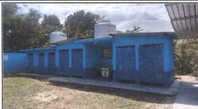
Foto1: Mantenimiento a estructura de puertas
