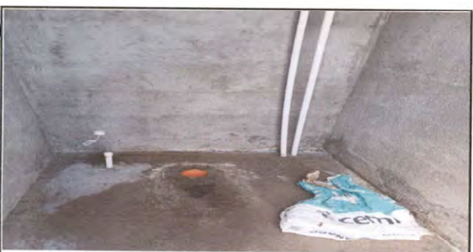
Foto 5: Sustitución de inodoros
