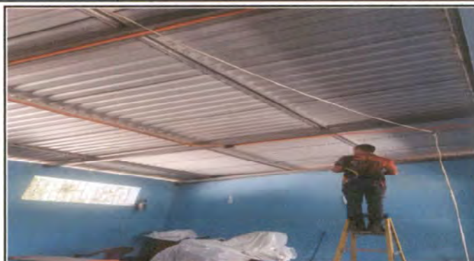
Foto 8: Reparación de cableado eléctrico
