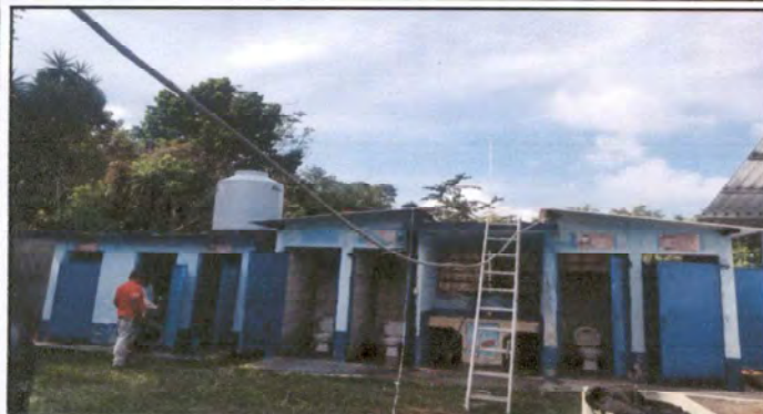
Foto 1: Mantenimiento a estructura de puertas
