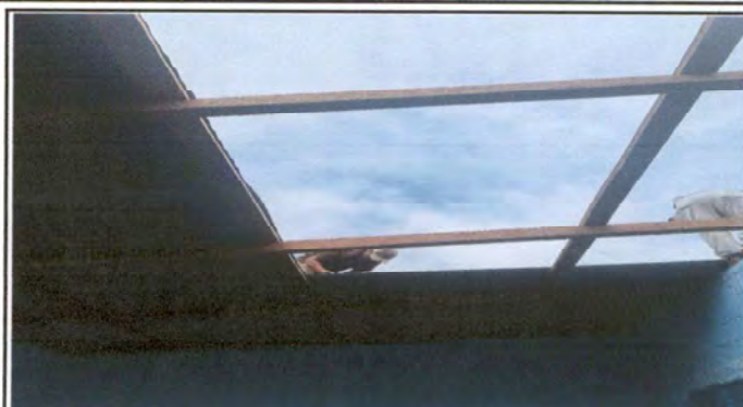
Foto 2: Sustitución de lámina, por lámina troquelada
