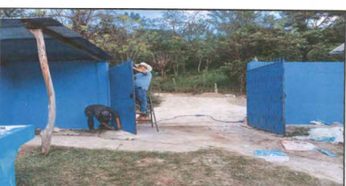
Foto 6: Mantenimiento a portón de metal
