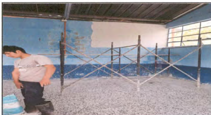
Foto 10: Repello de paredes de aula
