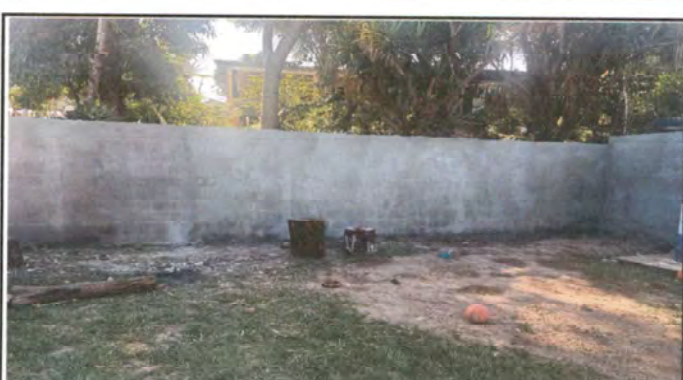
Foto 4: Pintura en muros exteriores e interiores
