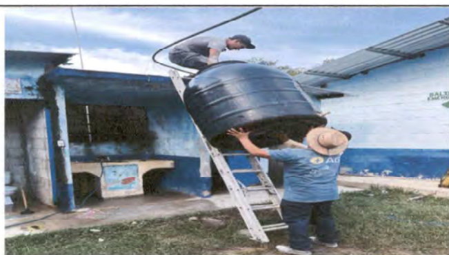
Foto 9: Sustitución de depósito de agua
