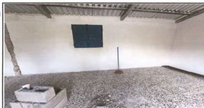
Foto 11: Repello de paredes de cocina
