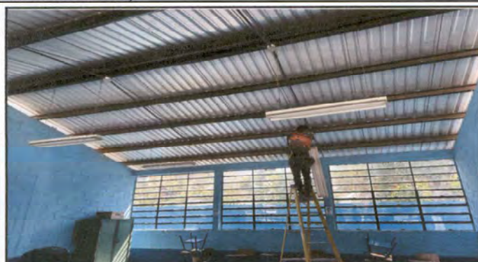
Foto 7: Sustitución de lámparas de 2 x 40
