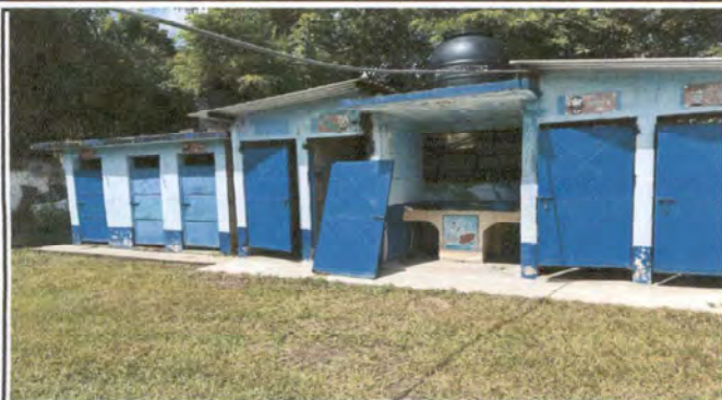
Foto 1: Mantenimiento a estructura de puertas
