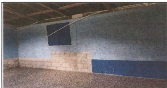
Foto 11: Repello de paredes de cocina
