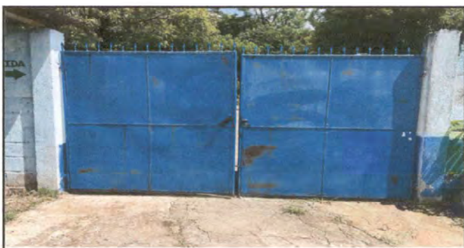
Foto 6: Mantenimiento a portón de metal
