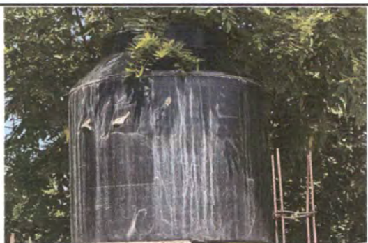
Foto 9: Sustitución de depósito de agua
