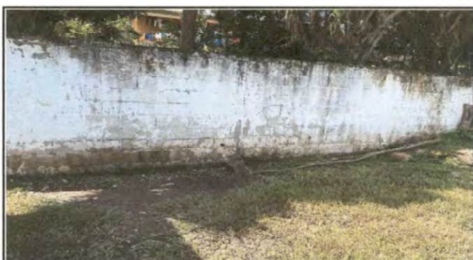
Foto 4: Pintura en muros exteriores e interiores
