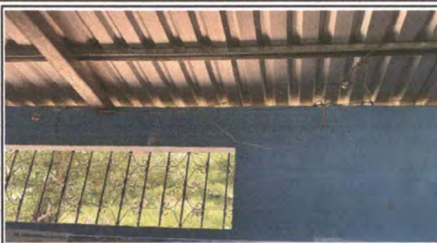
Foto 8: Reparación de cableado eléctrico
