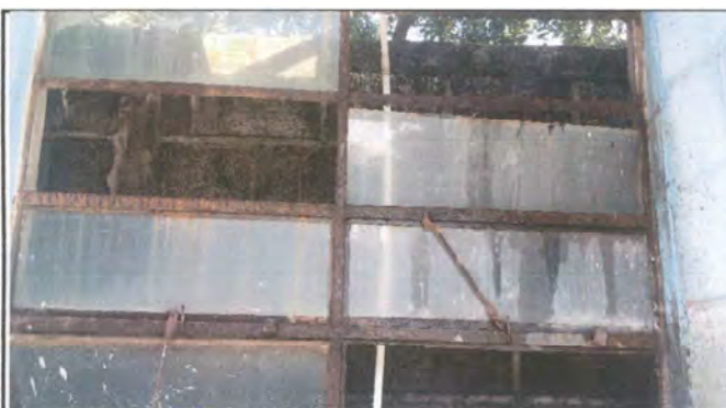
Foto 3: Mantenimiento a estructura de metal de ventana y sustitución de vidrios
