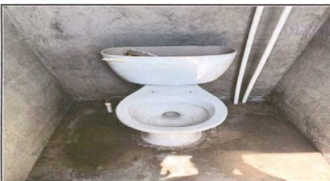
Foto 5: Sustitución de inodoros
