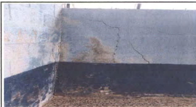
Foto 10: Repello de paredes de aula
