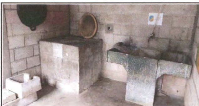
Foto 12: Sustitución de pila y estufa rural
