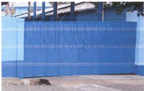
Foto 9: PINTURA DE PORTON FINALIZADO
