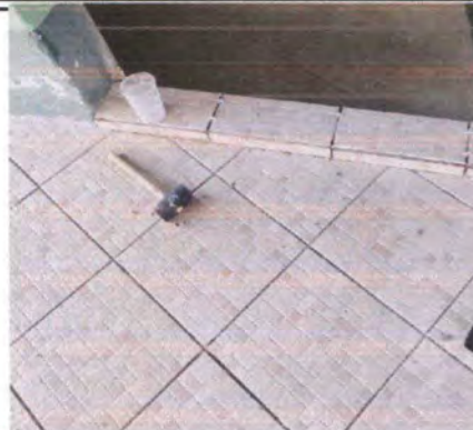
Foto 8: SUTITUCIÓN DE PISO EXTERIOR TERMINADO
