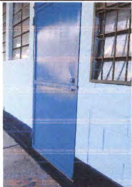
Foto 7: REPARACION Y PINTURA DE PUERTAS TERMINADO
