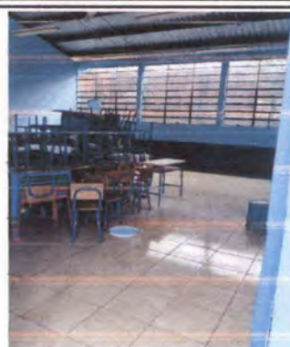
Foto 2: PISO DE AULAS REPARADO
