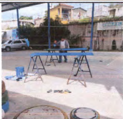
Foto 7: PINTANDO Y REPARANDO PUERTAS
