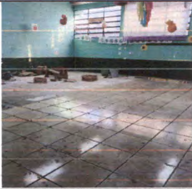
Foto 1: COLOCANDO PISO CERAMICO
