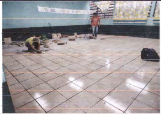
Foto 2: ALBAÑILES COLOCANDO PISO CERAMICO
