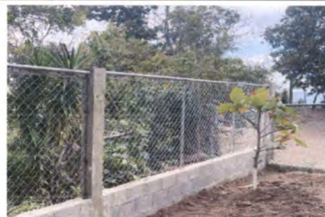
Foto 6: Muro perimetral completo de block y malla
