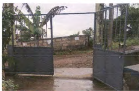
Foto 4: Mantenimiento de portón completado, lijado, ajustado, chapa nueva y pintura.
