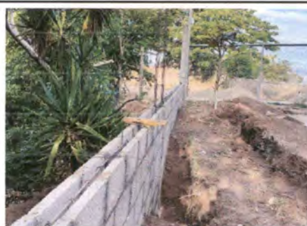
Foto 6: proceso de sustitución del muro perimetral.
