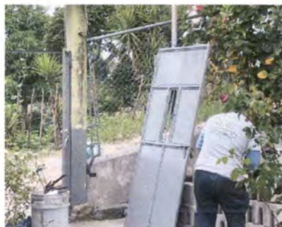
Foto 3: Proceso de mantenimiento a las puertas de los sanitarios, realizando la sujeción, lijado y pintura.
