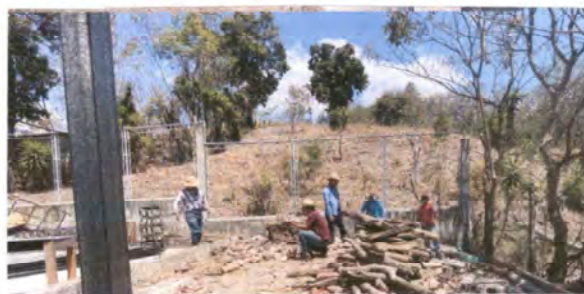
Foto 4: otro ángulo para la reparación de la losa de cemento para patio.
