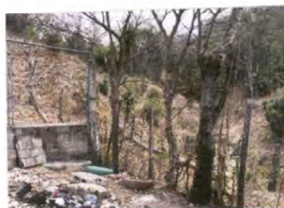
Foto 2: muro perimetral improvisado, con sus postes de madera picadas.
