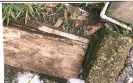
Foto 6: sustitución de la caja de registro de agua potable, no cuenta con tapadera y se quebraron partes de la caja.
