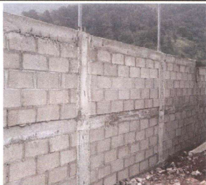
Foto 1: Muro perimetral de block.
