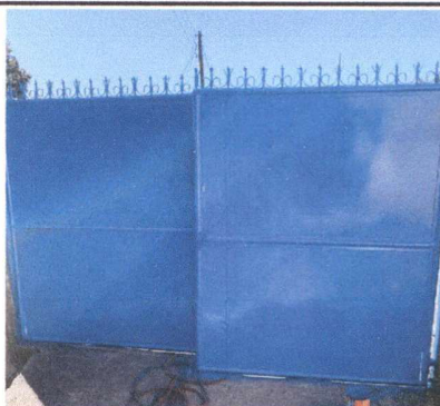
Foto 4: Mantenimiento a portones de metal
