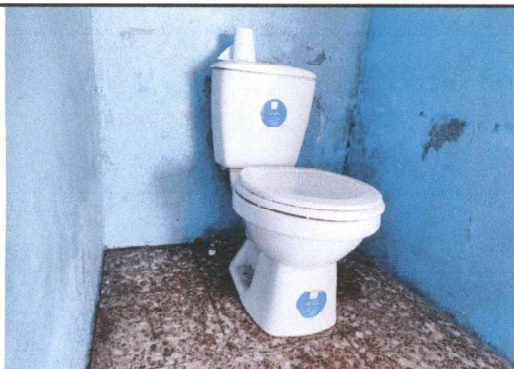
Foto 3: Sustitución de accesorios inodoro
