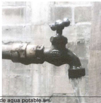
Foto 2: Red de agua potable
