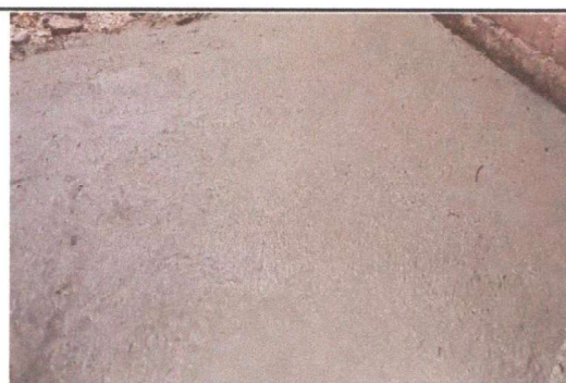
Foto 6: Reparación de planchas de concreto de patio
