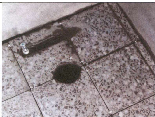
Foto 3: Sustitución de accesorios inodoro
