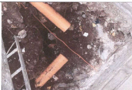
Foto 5: Sustitución de tubería PVC línea principal aguas pluviales (3 pulg o 4 pulg) y accesorios
