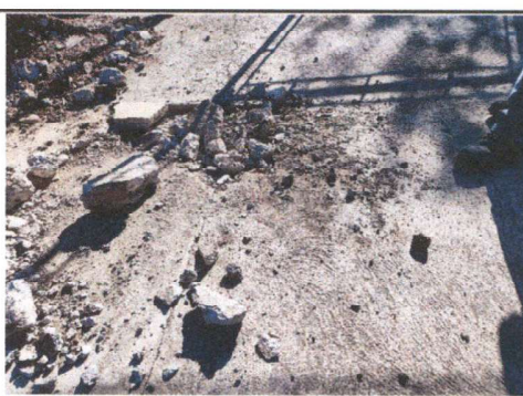
Foto 6: Reparación de planchas de concreto de patio
