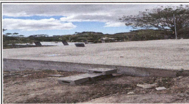
LOSA DE CEMENTO
