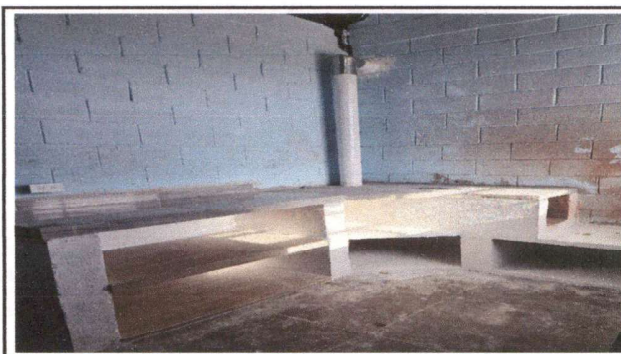
REPARACION DE COCINA
