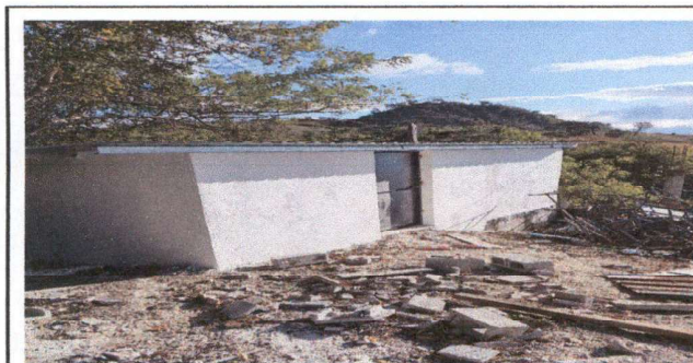
REPARACION DE BODEGA
