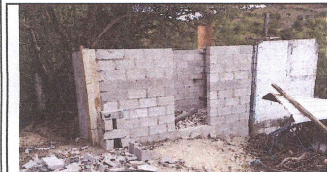
REPARACION DE BODEGA
