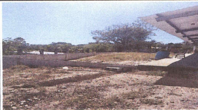
LOSA DE CEMENTO
