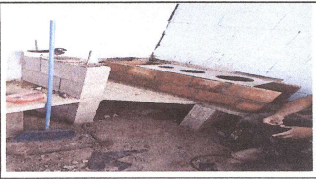
REPARACION DE COCINA
