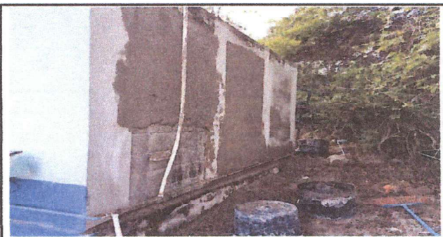
REPELLO DE PAREDES DE BAÑOS
