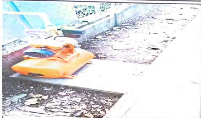
Foto1: Cambio de bomba para agua
