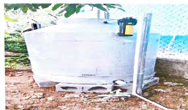
Foto 6: Sustitución de depósito de agua 1100 lt
