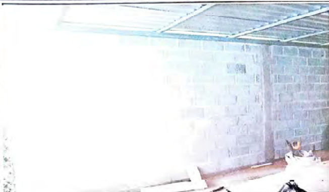
Foto1: Reparación de muro perimetral de block.
