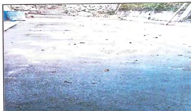
Foto 4: Reparación de planchas de concreto de patio
