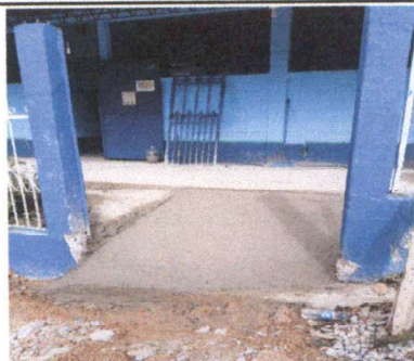
Foto 5: Reparación y ampliación de banquetta
