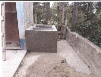
Foto 4: Instalación de pila
