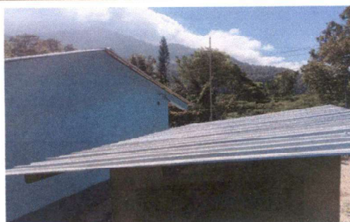
Foto 6: Sustitución de duralita por lámina troquelada calibre 26
