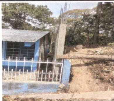
Foto 1: Reparación de muro perimetral de block
