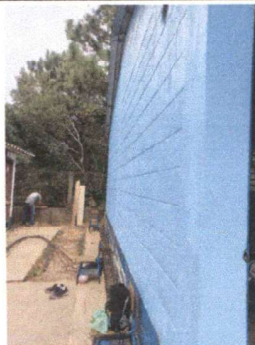
Foto 2: Pintura en muros exteriores e interiores
