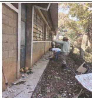
Foto 5: Reparación y ampliación de banqueta
