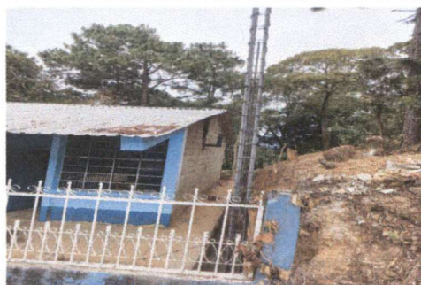
Foto 1: Reparación de muro perimetral de block
