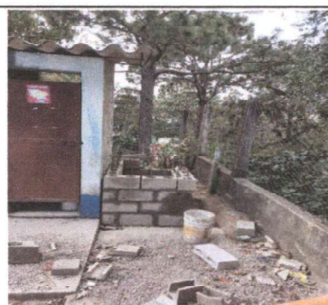
Foto 4: Instalación de pila
