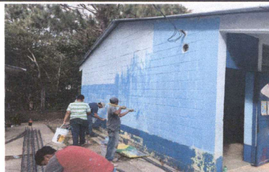
Foto 2: Pintura en muros exteriores e interiores
