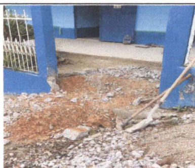
Foto 3: Reparación de piso de torta de concreto
