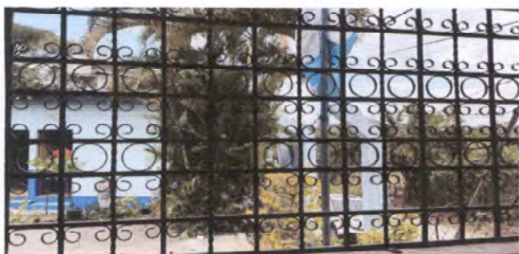
Foto 7: Mantenimiento de balcones, pintura.
