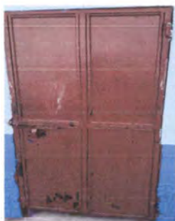
Foto 11: Mantenimiento de puertas de metal.
