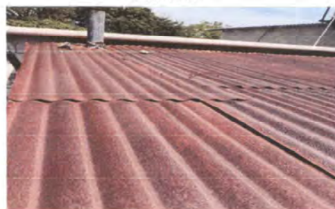
Foto 2: Sustitución de chimenea de la cocina.
