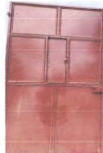
Repación de puertas
