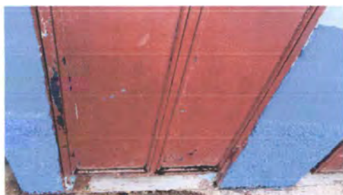
Foto 5: Sustitución de puertas de metal para sanitarios.
