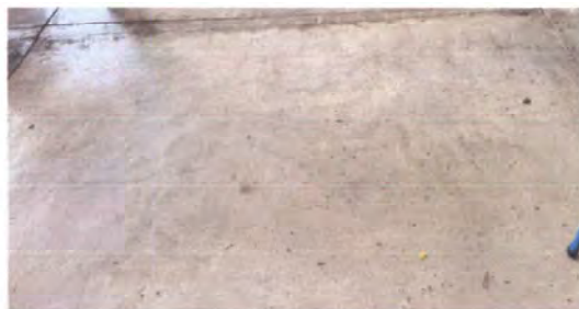
Foto 10: Colcación de piso de cerámico.
