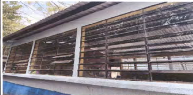
Foto 8: Sustitución de ventanas de vidrios por ventanas corredizas.
