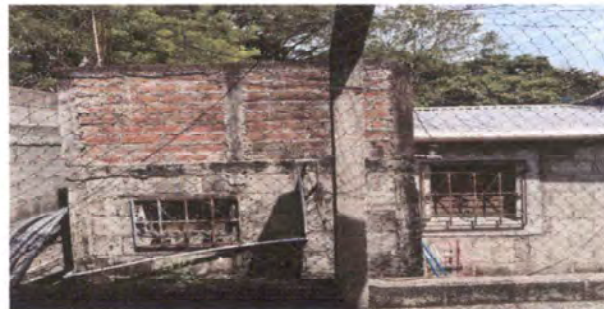
Foto 4: Reparación y ampliación de muro perimetral.
