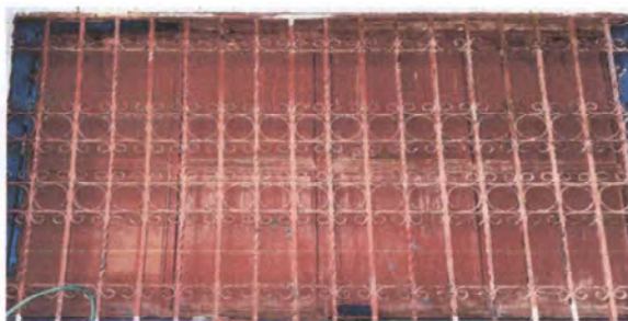
Foto 9: Sustitución de balcón por falta de reparación.
