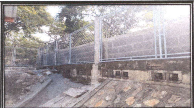
Foto 3: Reparación de muro perimetral con malla galvanizada
