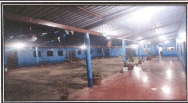
Foto1: Reparación de sistema eléctrico
