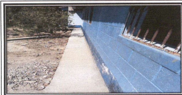
Foto 5: Reparación de banqueta de concreto
