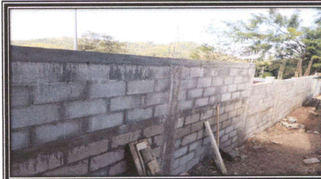
Foto 4: Sustitución de muro perimetral por muro de block ( materiales y mano de obra)
