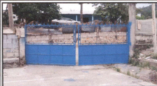
Foto 2: Mantenimiento de portones
