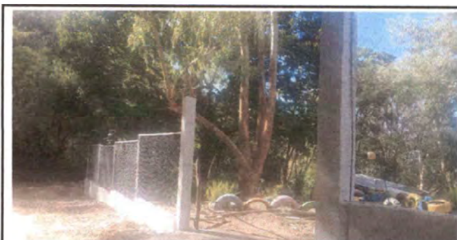
Foto 6: Cambio de cerca por tubo cuadrado galvanizado y malla galvanizada
