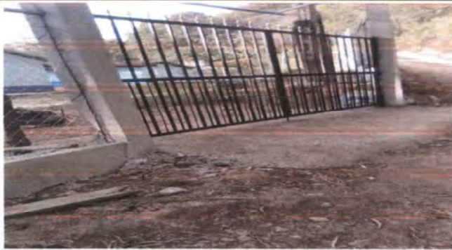
Foto 7: Cambio de porton
