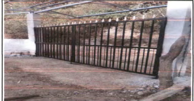
Foto 8: Reparación de columnas y fundición de plancha de concreto entrada
