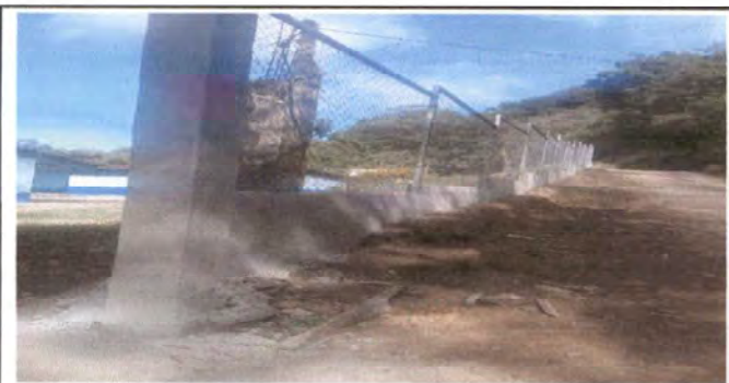
Foto 5: cambio de cerca por block
