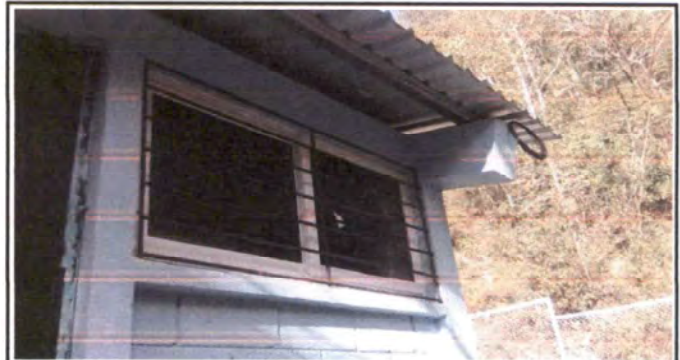
Foto 10: Instalación de balcones de metal
