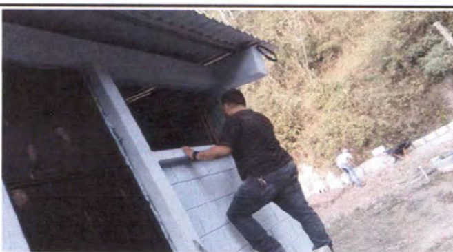
Foto 10: Instalación de balcones de metal
