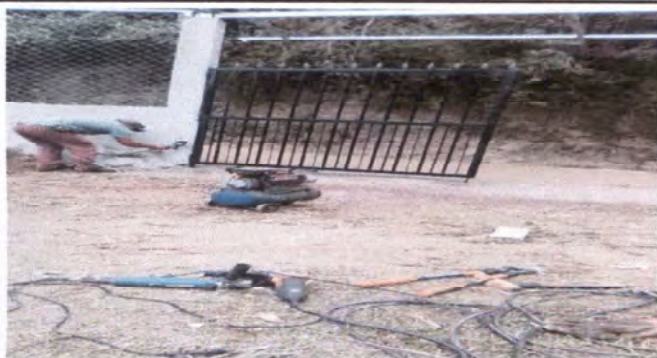
Foto7: Cambio de porton
