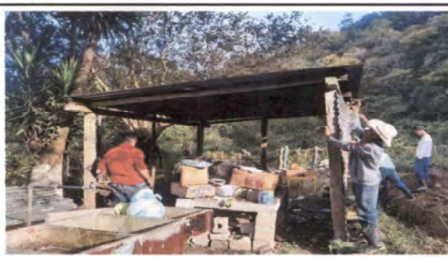
Foto 4: Cambio de lámina del área de la pila
