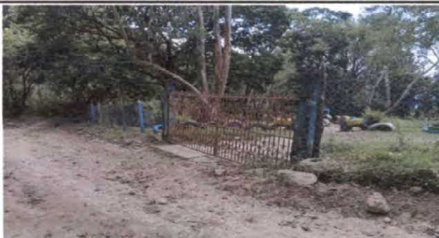
Foto 6: Cambio de serca por tubo cuadrado galvanizado y malla galvanizada
