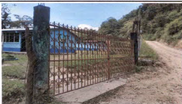
Foto 7: Cambio de portón
