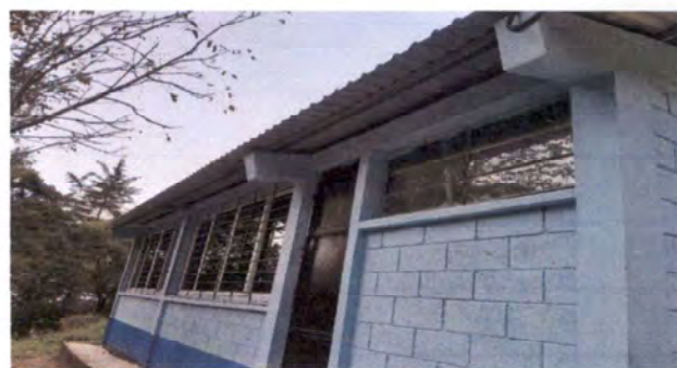
Foto 10: Instalación de balcones de metal
