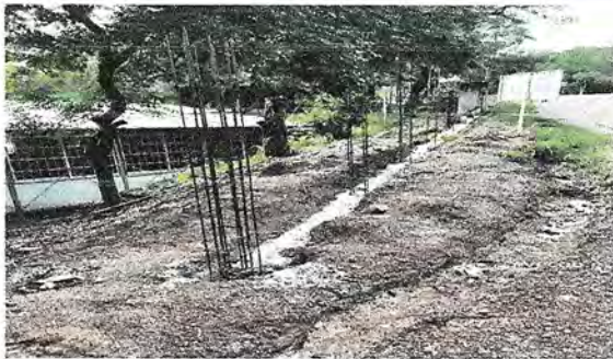
FOTO 3: CIRCULACIÓN EN LA PARTE DE ATRÁS
