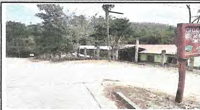
FOTO 1: CIRCULACIÓN EN MAL ESTADO
