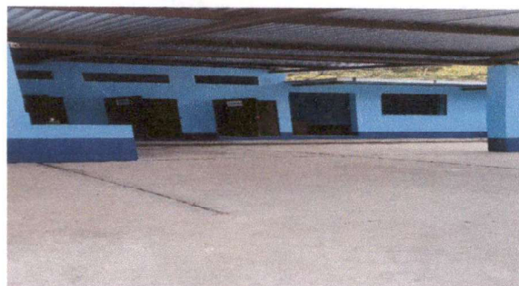
Foto 4: Sustrucción de lámina en cocina por lámina troquelada aluzinc calibre 26, reparación de planchas de concreto de patio y sustitución de focos ahorradores.
