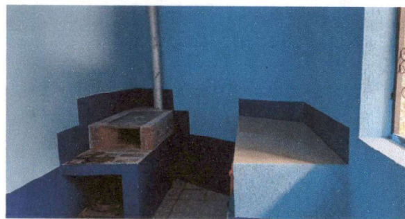
Foto 2: Sustrucción de estufa rural completa e instalación de azulejo en estufa rural.
