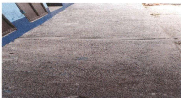
Foto 1: Sustrucción de torta de concreto en banqueta de baños y sustitución de piso de torta a granito en bodega, cocina y baños.
