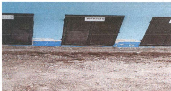
Foto1: Sustrución de torta de concreto en banqueta de baños y sustrución de piso de torta a granito en bodega, cocina y baños.
