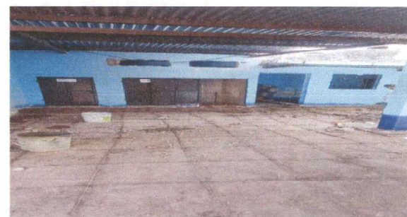
Foto 4: Sustrución de lámina en cocina por lámina troquelada aluzinc calibre 26, reparación de planchas de concreto de patio y sustrución de focos ahorradores.
