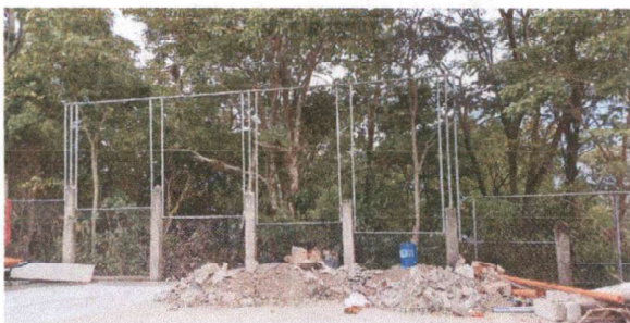
Foto 5: Reparación de muro perimetral de malla galvanizada solares intermedias y columnas.
