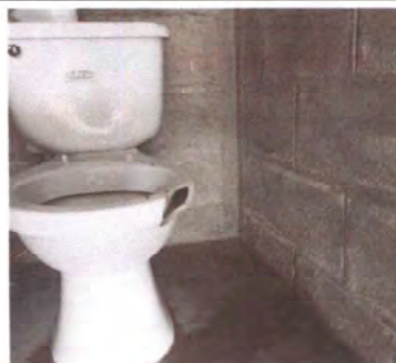
Foto 6: Sustitución de inodoros
