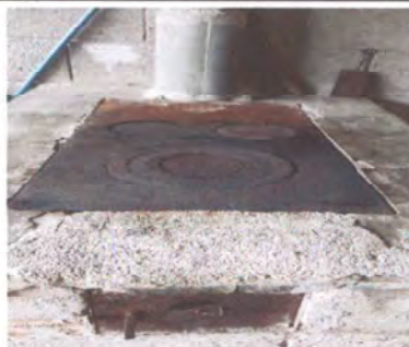
Foto 2: Sustitución de cocina Rural completa
