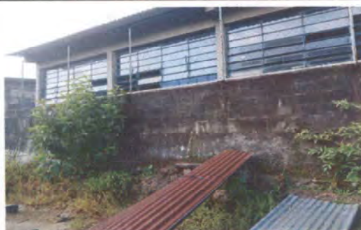
Foto 1: Reparación de Muro de contención
