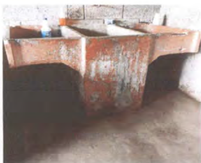
Foto1: Sustitución de pila
