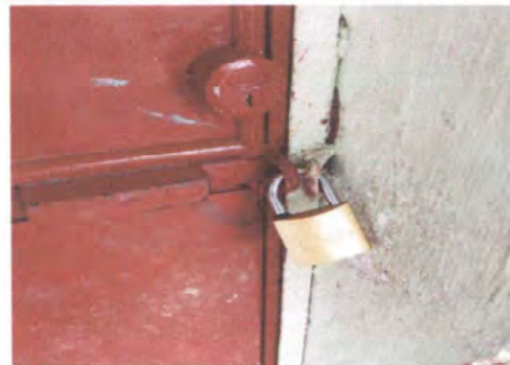
Foto 4: Lijada y pintura de puertas
