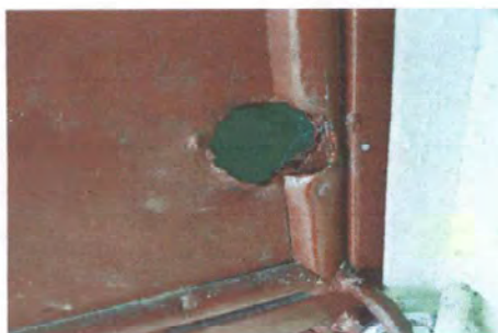
Foto 5: Sustitución de chapas de las puertas
