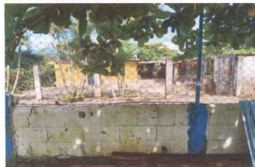
Foto 2: Reparación de Malla Galvanizada
