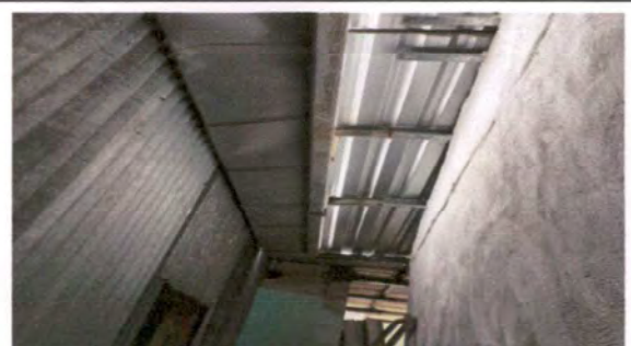
Foto 6: Sustitución de canal de metal
