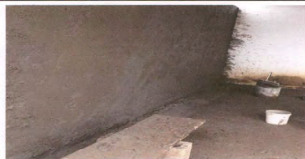
Foto 5: Reparación de muro perimetral de block.
