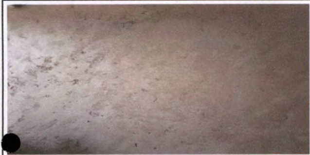
Foto 7: Repello en muro
