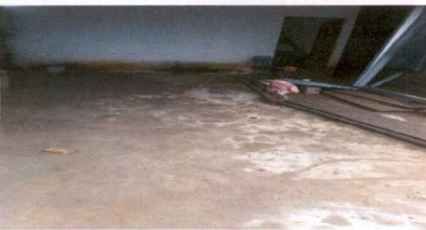
Foto 3: Reparación de piso de torta de concreto
