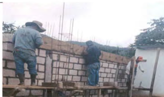
Foto 4: Reparación de muro de perimetral de block
