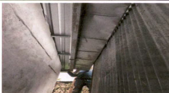
Foto 6: Sustitución de canal de metal
