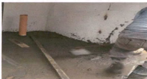
Foto 5: Sustitución de tubería PVC línea principal aguas negras (3 pulg o 4 pulg)
