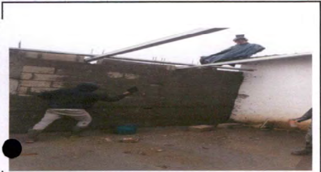
Foto 7: Repello en muro
