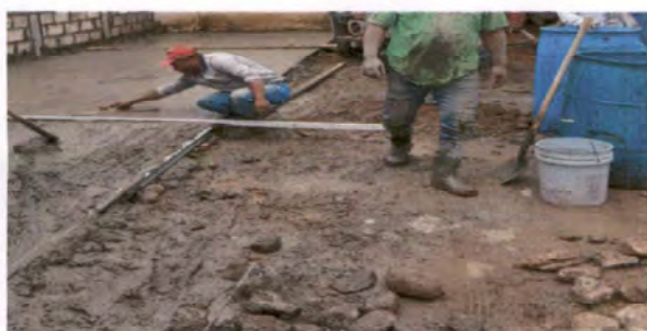
Foto 3: Reparación de piso de torta de concreto
