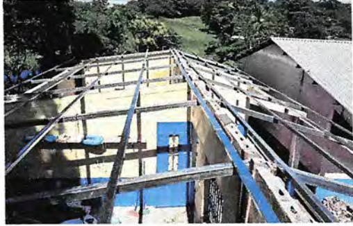
Foto 2: 2.2 sustitución de estructura de soporte de madera por metal
