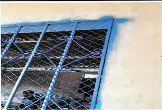
Foto 5: 5.7 mantenimiento a balcones de metal.
