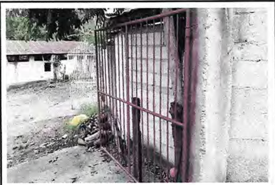
Foto7: 12.1mantenimiento a portones de metal
