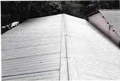
Foto1: 1.1 sustitución de lámina por lámina troquelada aluzinc calibre 26
