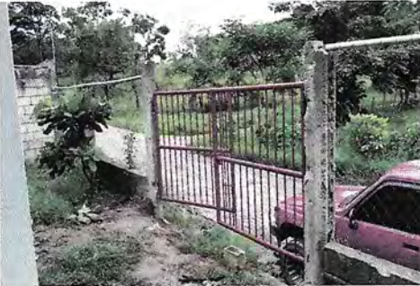
Foto 4: 4.5 sustitución de portón de metal
