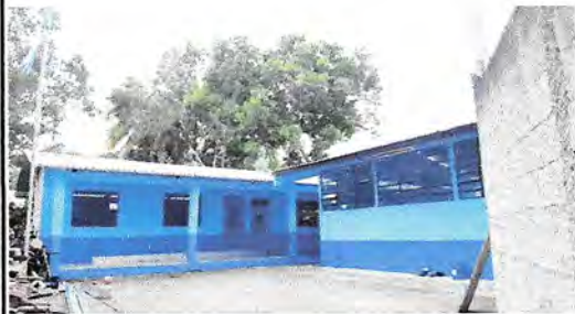
Foto 6: 9.1 pintura en muros exteriores e interiores
