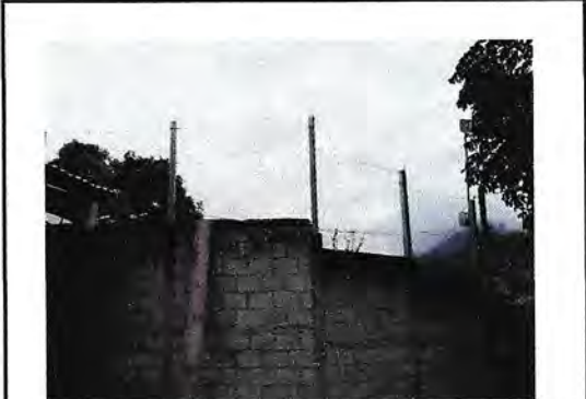
Foto 8: 15.2 Reparación de muro perimetral de block con tubo hg y malla galvanizada, soleras intermedias y columnas.
