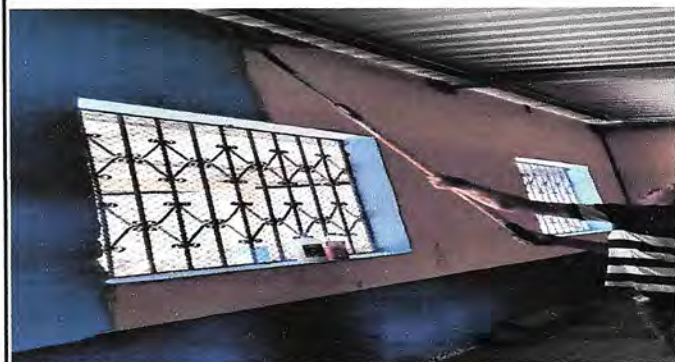
Foto 6: 9.1pintura en muros exteriores e interiores
