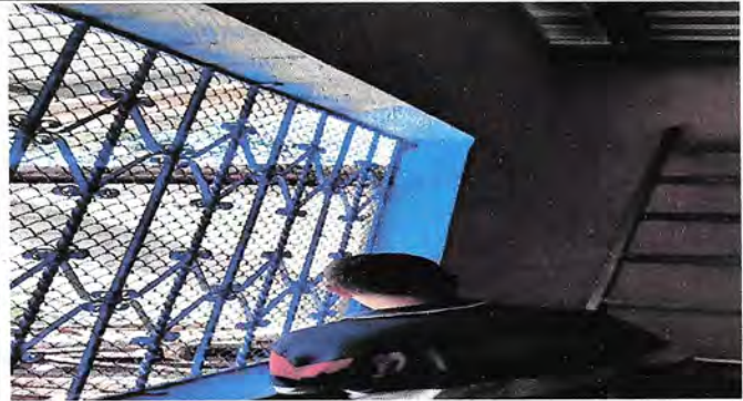
Foto 5: 5.7 mantenimiento a balcones de metal.
