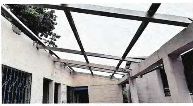
Foto 2: 2.2 sustitucion de estructura de soporte de madera por metal
