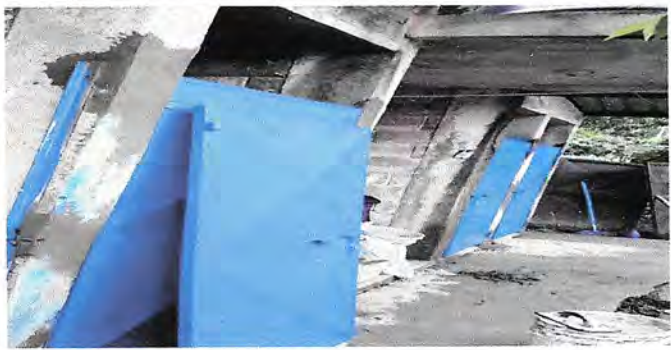
Foto 3: 4.4 sustitución de puerta de servicios sanitarios
