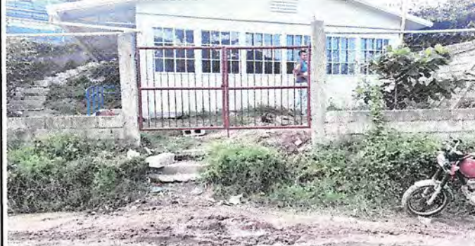
Foto 4: 4.5 sustitución de portón de metal
