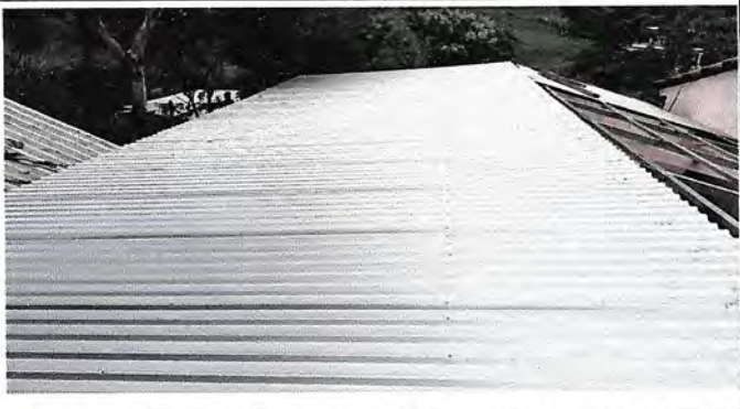
Foto1: 1.1 sustitucion de lámina por lámina troquelada aluzinc calibre 26
