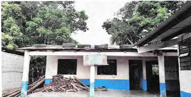
Foto 6: 9.1 pintura en muros exteriores e interiores
