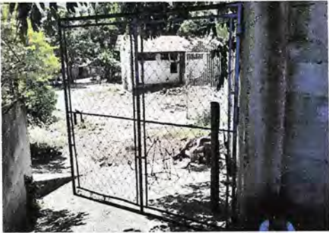
Foto7: 12.1mantenimiento a portones de metal
