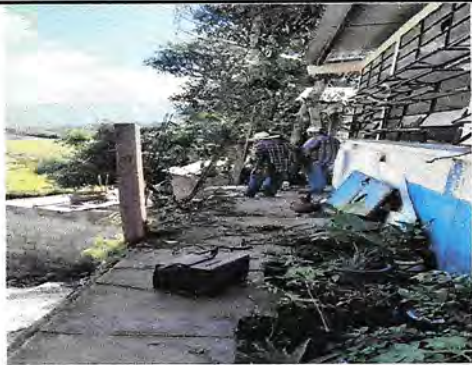
Foto 3: 15.3 Reparación de tubo hg y malla galvanizada
