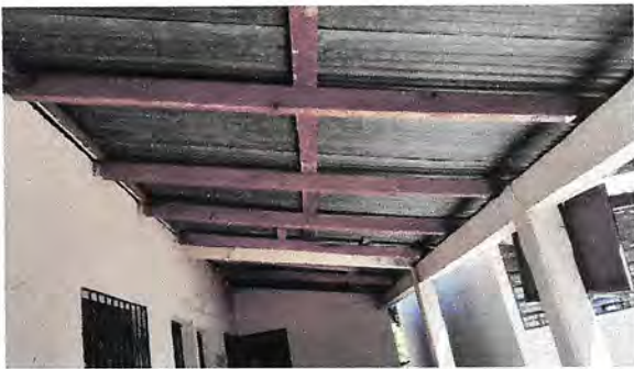
Foto 2: 2.2 sustitucion de soporte de madera por metal
