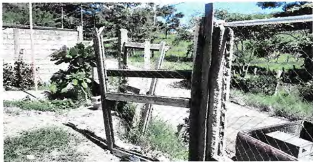
Foto 4: 4.5 sustitución de portón de metal
