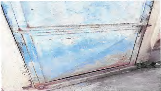
Foto 3: 4.4 sustitución de puerta de servicios sanitarios
