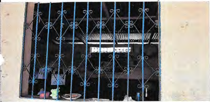
Foto 5: 5.7 mantenimiento a balcones de metal.
