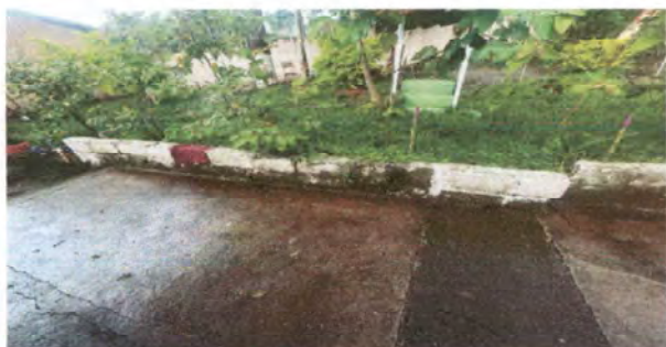
Foto 1 Muro de contención
