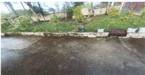
Foto 3: Muro de contención
