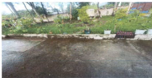
Foto 2 Muro de contención
