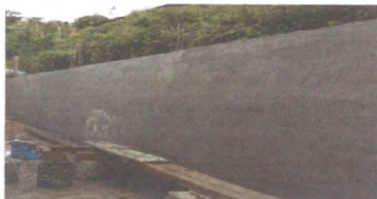
Foto 5: REPARACIÓN DE MURO PERIMETRAL
