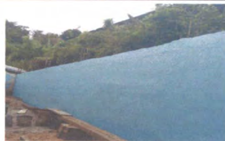
FOTO 10: PINTURA EN MURO PERIMETRAL
