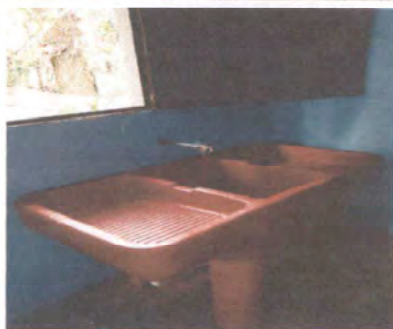
FOTO 3: SUSTITUCIÓN DE PILA PLASTICA
