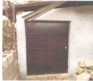
FOTO 8: SUSTITUCIÓN DE PUERTA DE METAL
