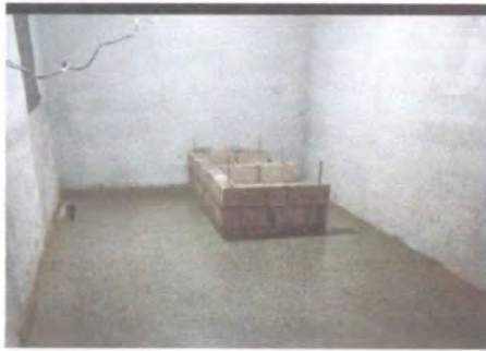
FOTO 7: REPELLO Y CERNIDO EN PAREDES
