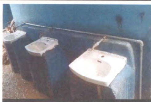
FOTO 4: SUSTITUCIÓN DE TUBERÍA Y LLAVES EN LAVAMANOS
