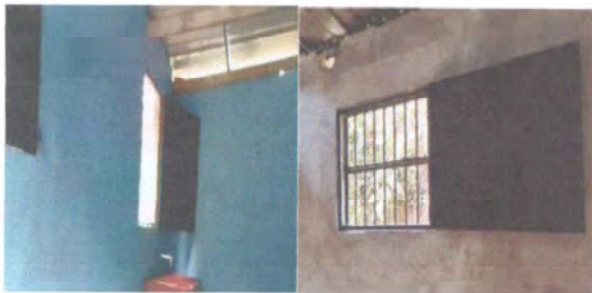
FOTO 9: SUSTITUCIÓN DE VENTANAS DE METAL
