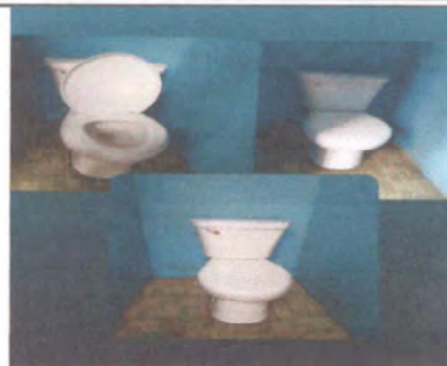
FOTO 2: SUSTITUCIÓN DE INODOROS
