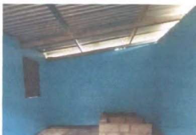
Foto 11: SUSTITUCIÓN DE ESTRUCTURA Y LÁMINA TROQUELADA
