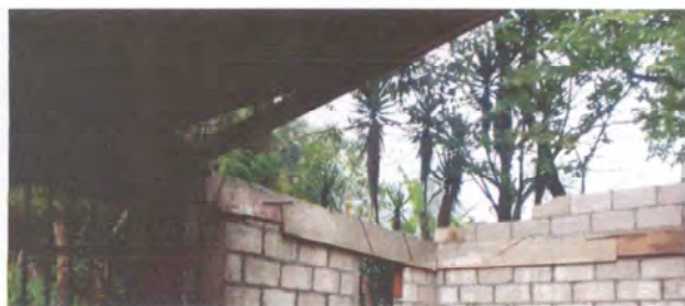
FOTO 11: SUSTITUCIÓN DE ESTRUCTURA Y LÁMINA TROQUELADA
