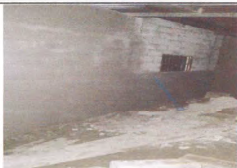
FOTO 7: REPELLO Y CERNIDO EN PAREDES
