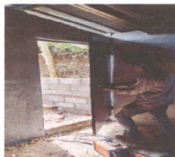
Foto 8: SUSTITUCIÓN DE PUERTAS DE METAL
