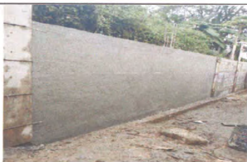
Foto 5: REPARACIÓN DE MURO PERIMETRAL REPELO Y CERNIDO
