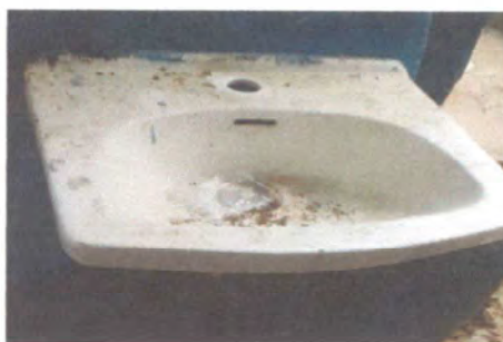
Foto 4: SUSTITUCIÓN DE TUBERÍA Y LLAVES EN LAVAMANOS
