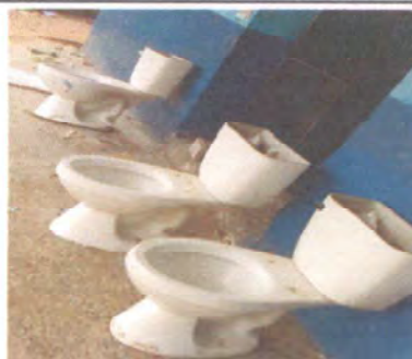
FOTO 2: SUSTITUCIÓN DE INODOROS
