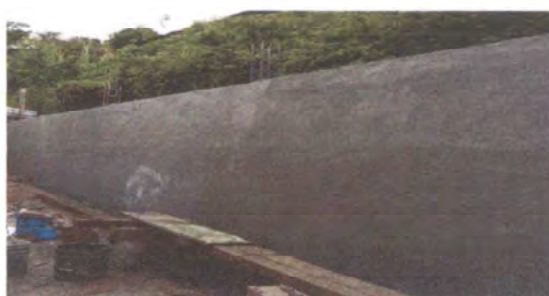
Foto 10: PINTURA EN MURO PERIMETRAL
