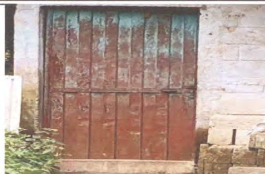
FOTO 8 SUSTITUCIÓN DE PUERTA DE METAL
