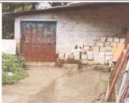
FOTO 7 REPELLO Y CERNIDO EN PAREDES
