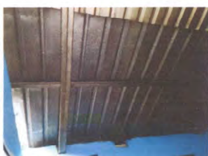
FOTO 11 SUSTITUCIÓN DE ESTRUCTURA Y LAMINA TROQUELADA
