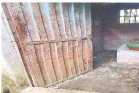
FOTO 1: SUSTITUCIÓN DE PISO DE GRANITO
