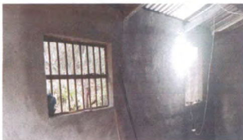
Foto 9: SUSTITUCIÓN DE VENTANAS DE METAL
