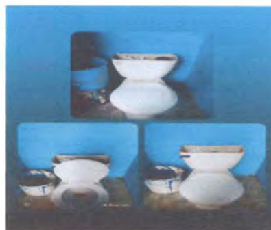
FOTO 2: SUSTITUCIÓN DE INODOROS
