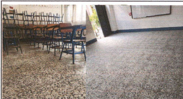
Foto 4: En este salón el piso de concreto estaba muy dañado y fue sustituido por granito. Ahora los estudiantes y maestros podrán disfrutar de un espacio más agradable.
