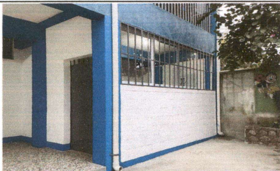
Foto 3: La reparación del muro perimetral de la dirección con block, colocación de ventana y ventanal ofrecen seguridad a la dirección del establecimiento donde se resguarda mobiliario, equipo y documentos de archivo.
