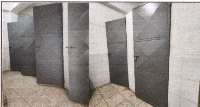
Foto 6: Se les dio mantenimiento a las puertas con lijado, cepillado y aplicación de pintura por deterioro, ya que estaban oxidadas y con ello se prolonga su funcionalidad.
