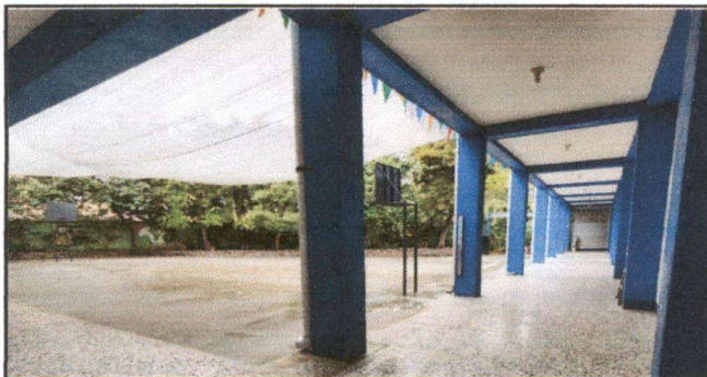
Foto 5: El piso de concreto que estaba bien dañado se sustituyó por granito, era un espacio que está pendiente de remozar ya que el otro pasillo es de granito.
