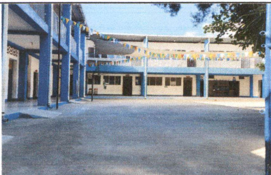
Foto 1: Las planchas de concreto fueron reparadas y ahora este espacio que se utiliza para recreación, reuniones generales de padres de familia, actos cívicos y la clase de Educación Física, hoy se encuentra en buen estado.
