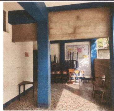
Foto 2: Se han quitado los materiales que dividían esta área y se ha iniciado con la colocación de block. Se considera un avance físico del 30%
