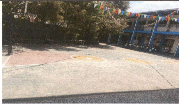
Foto 1: El concreto del patio está muy dañado y representa un riesgo para los estudiantes puesto que es la única área que se utiliza para recreación y la clase de Educación Física. 0% de ejecución a la fecha.
