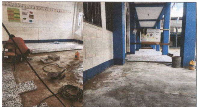
Foto 4: La sustitución del piso de concreto por granito en el salón de tercero "C", está avanzando sin ningún inconveniente, se calcula que lleva un avance físico del 80 %.
