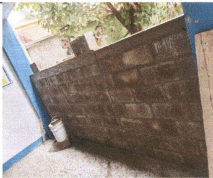
Foto 3: En la repación del muro perimetral de la dirección del establecimiento, han iniciado los trabajos con derribar la estructura de madera que estaba y se está trabajando la colocación de block. Se calcula un 25% de avance físico.
