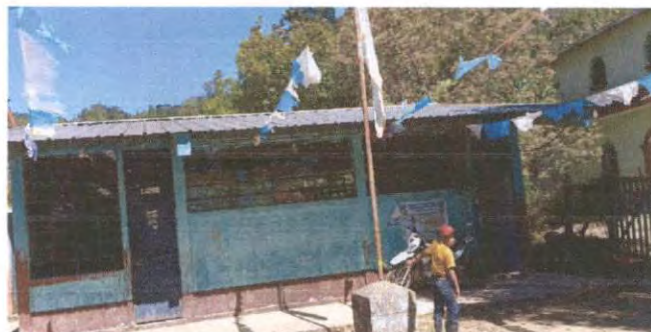
Foto 2: sustitución de vidrios.
