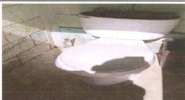
Foto 5: Sustitución de accesorios de inodoros.
