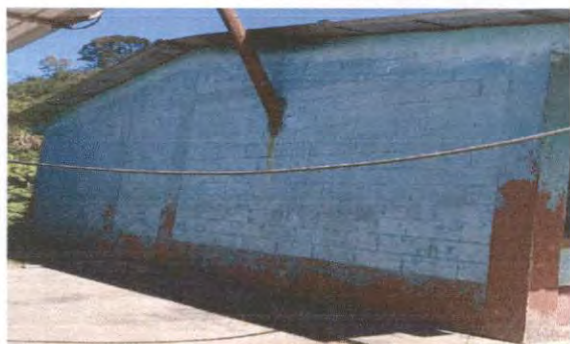
Foto 3: Pintura en muros exteriores e interiores.
