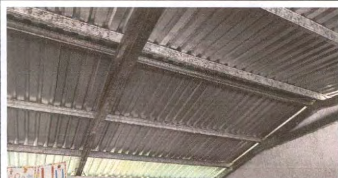
Foto 10: Sustitución de plafoneras
