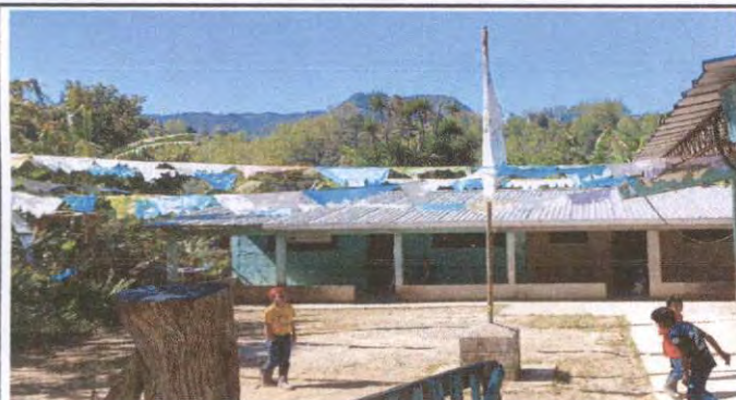
Foto 8: Reparación de plancha de Concreto
