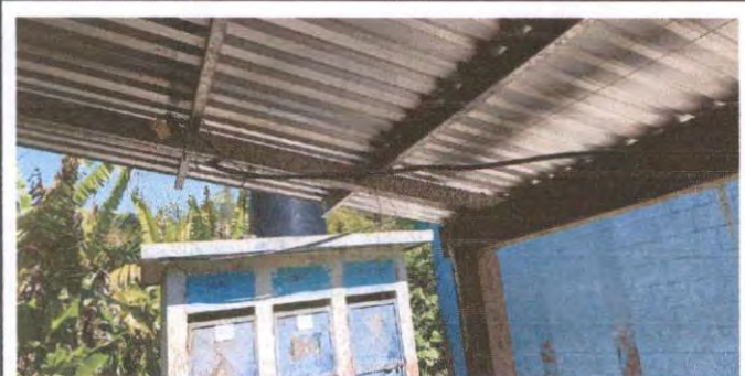
Foto 12: Sustitución de tomacorrientes dobles.
