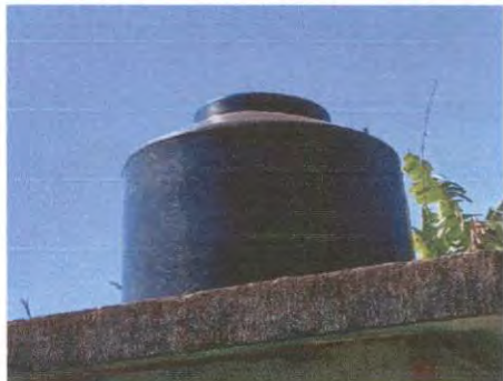
Foto 6: Reparación de bomba de agua.
