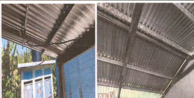
Foto 13: Reparación de cableado eléctrico.
