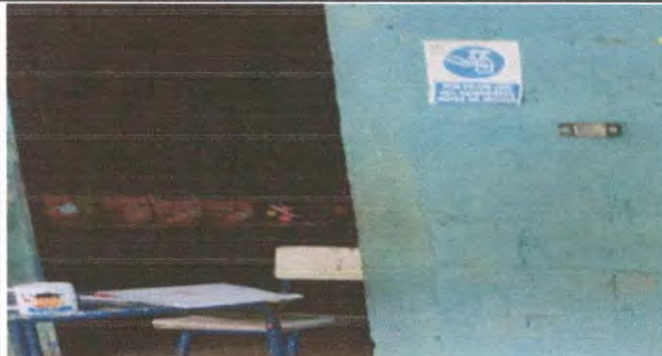
Foto 11: Sustitución interruptores simples.
