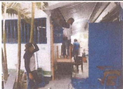
Foto 5: Sustitución de ventanas de malla por estructura de metal
