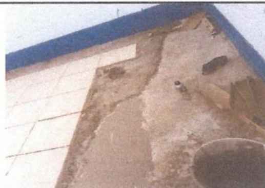
Foto 6: Sustitución de Piso de torta de concreto por piso ceramico
