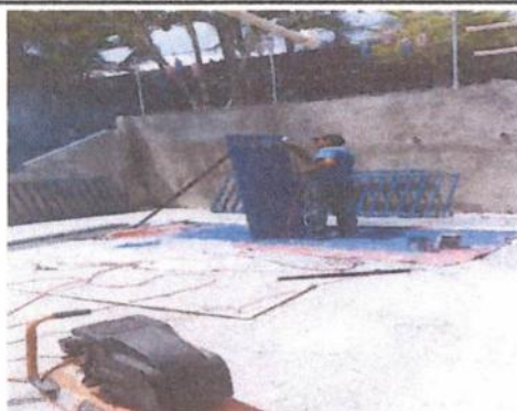
Foto 3: Mantenimiento de estructura de puertas
