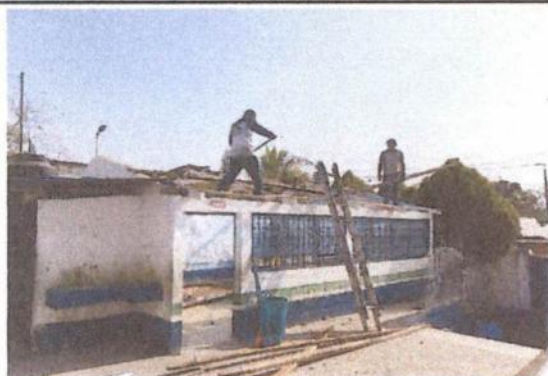
Foto 1: Sustitución de lámina por lámina troquelada
